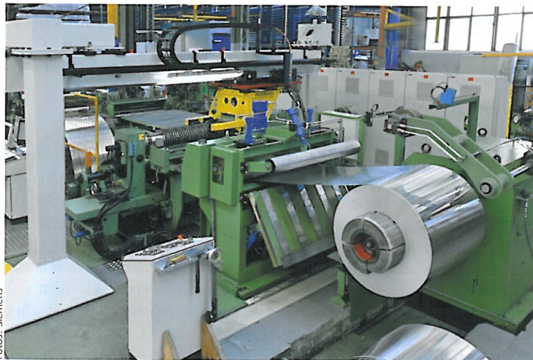
Die vorhandenen Gleichstromantriebe der Band-Spaltanlage für Abwickler, Schere und Aufwickler werden über Sinamics DCM angesteuert
