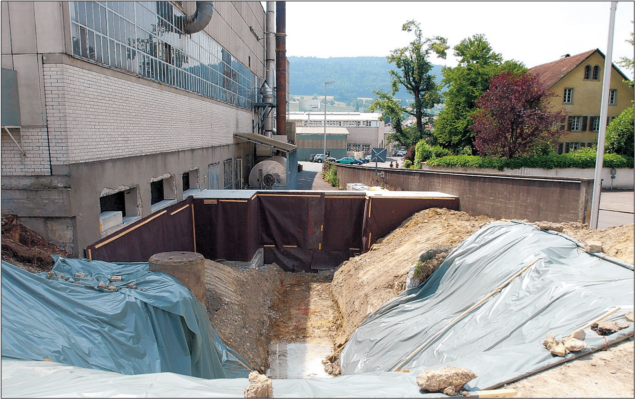
Baugrube für den Flüssiggastank mit 62'000 Liter Nenninhalt, welcher in die Erde verlegt wird.
