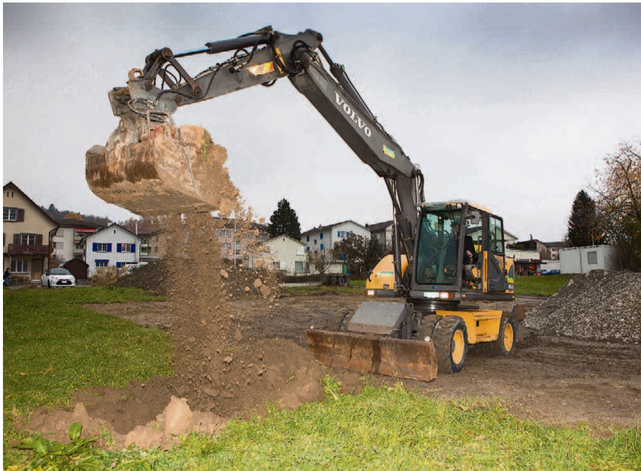
Für einmal ein Baggerstich: Geschäftsführer Matthias Ruch beginnt mit dem Aushub.
