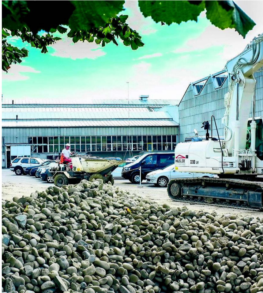
Die Arbeiten für die neue Erschliessung sind im Gang.
