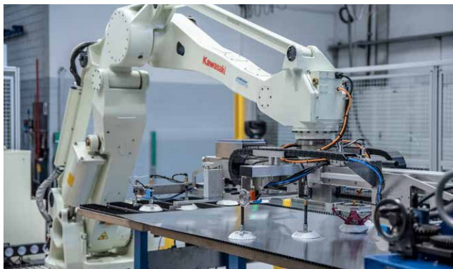
Installation de brossage
