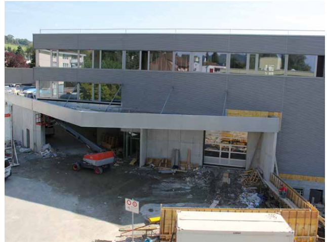
Wird in Kürze in Betrieb genommen: die zusätzliche Betriebsfläche von 3000 m 2 mit neuem Bürotrakt.
