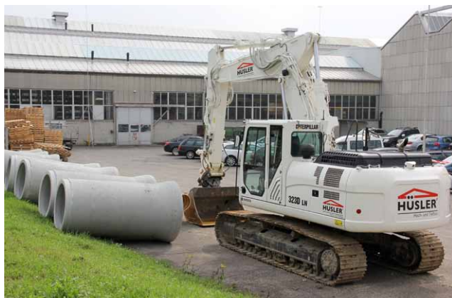
Die Vorarbeiten für die Betriebserweiterung laufen bereits
